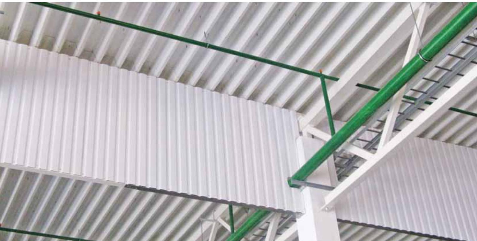
Стены здания выполняются в варианте полистовой сборки с минераловатным утеплителем. Утеплитель аналогичен применяемому в кровле. Наружная и внутренняя обшивка выполняются из профилированного листа ВС-18. Материал обшивок изготавливается из оцинкованной и окрашенной листовой стали. При неутепленном стеновом ограждении наружная обшивка выполняется только из профилированного листа ВС-18. Ограждающие конструкции стен включают в себя все необходимые нащельники и крепеж.
