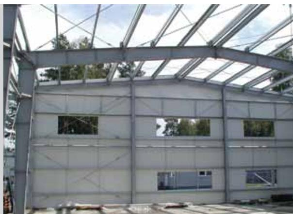
Прогонная система кровли выполнена по неразрезной схеме и изготавливается из оцинкованных Z-прогонов. Стеновые прогоны - разрезные и изготавливаются из оцинкованных С-прогонов. Элементы конструкции имеют только болтовые соединения.
