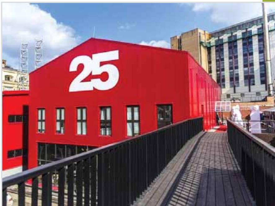
Монтаж по многопролетной неразрезной схеме на всю высоту здания (13,4 м), панель толщиной 150 мм
