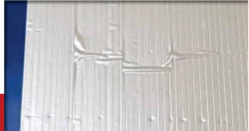
Низкое качество изготовленных панелей приводит к появлению дефектов еще в процессе монтажа
