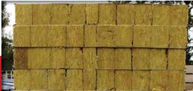
**Зазоры между ламелями** – снижение теплоизолирующей способности и пожаростойкости ограждающей конструкции в целом
