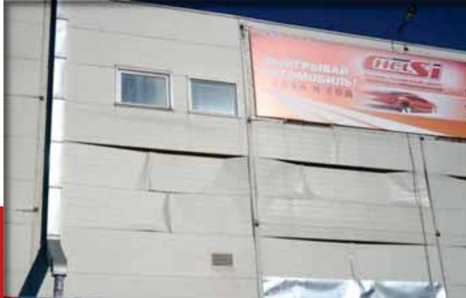
**Низкая жесткость** трехслойной конструкции панели – ненормативный прогиб от внешних воздействий
